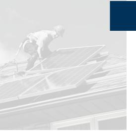
• Le BP chargé d'opérations BT élémentaires chaîne PV peut monter/démonter les connecteurs débrochables, manipuler des modules PV, connecter des modules PV à une chaîne PV
